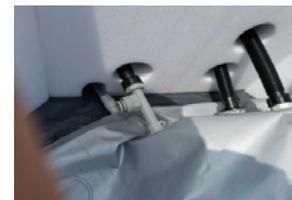
7) Installez le tuyau de raccordement (assemblez le tuyau court et le raccord en T comme illustré sur le schéma).
