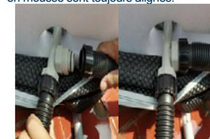
9) Connectez le tuyau de raccordement le plus long au raccord en T comme illustré sur le schéma.
